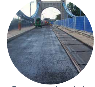
Prace z nawierzchnią można rozpocząć po 4 godzinach
